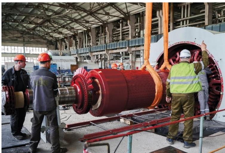
В рамках правительственной программы модернизации генерирующих мощностей (ДПМ-2) на Смоленской ТЭЦ-2 реализуется проект по модернизации турбогенератора ТГ-3 с комплексной заменой турбоагрегата Т-110/120-130-4 на Т-130/145-12,8-NG мощностью 130 МВт и проект по модернизации турбогенератора ТГ-2 с комплексной заменой турбоагрегата Т-100/120-130-2 на Т-130/145-12,8-NG мощностью 126 МВт. После пуска
